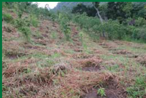
Figura 79: Reforma de coroamento.
